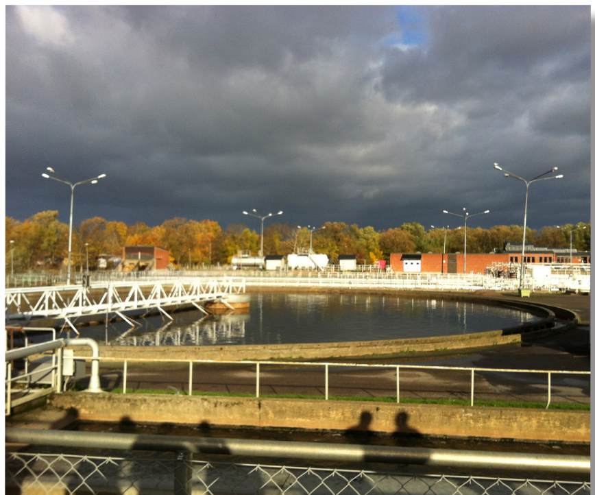
Nykvarns avloppsreningsverk. Foto: Susanne Holmström
